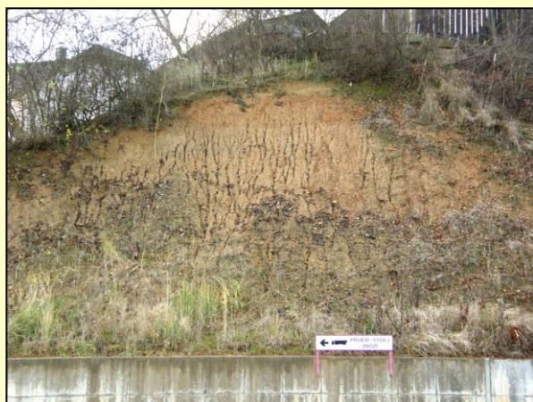
Plzeň, Košutka (2009) Stejná stěna ze sprašových hlin na Košutce u obchodního areálu (bývalé cihelně) jako na obrázku nahoře, ale po deseti letech. Patrná je rychlá eroze a zarůstání vegetací. Dobře patrná je starší (světlejší) a mladší (tmavší horní) poloha sprašových hlin.
