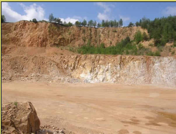
Lom Třebnuška (2009) Dvě etáže činného lomu v kambrických ryolitech u Třebnušky. Kámen se využívá jako drcené kamenivo pro stavební účely.
