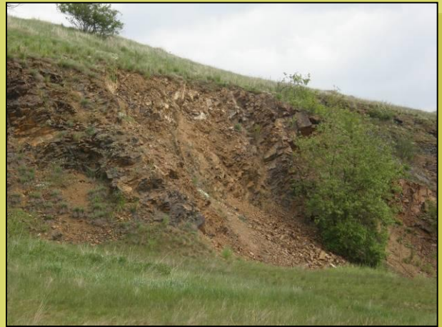
Terešovská hut' (2009) Deskovitý rozpad porfyritů.
