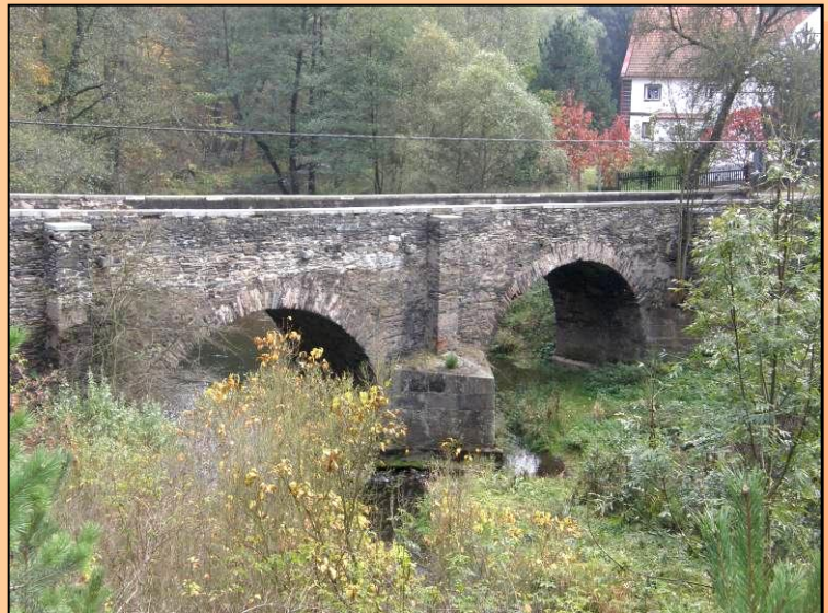
Rabštejn (2009) Most nad Střelou je rovněž z fylitů, i když pro základy pilířů byl využit pevnější materiál místních žul.
